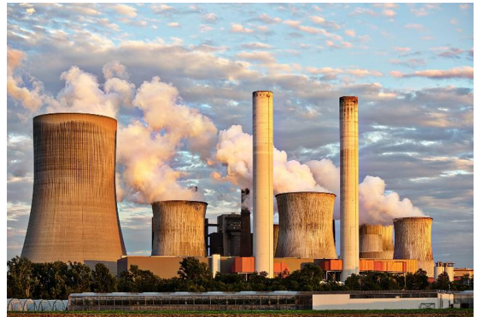
Kühltürme einer Industrieanlage.
